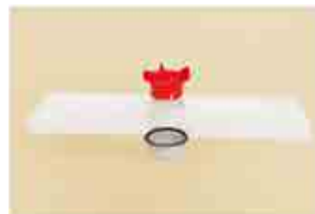
12. Ievietojiet novadīšanas vārstu dušas paliktņa atverē un, izmantojot montāžas atslēgu un (vai) aizsargvāciņu, pievilkt uzgriežnim tā, lai tā blīvēšanas lente cieši piespiestos apakšējai dušas paliktņa daļai (hermētiskums !!!).
