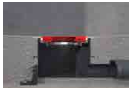
15. Pārklājumu izlīdziniet atbilstoši apaļam nerūsējoša tērauda rāmim.
