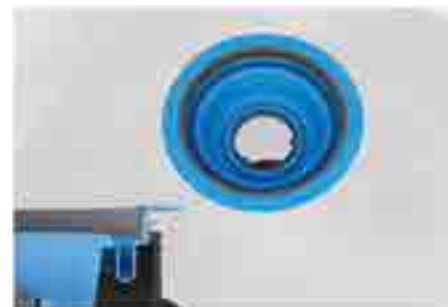
9. Ūdens novadīšanas ierīcē ievietojiet hidroizolācijas komplektu ar integrētu „flex” elementu, apgrieziet aizsargvāciņu un atkal ievietojiet.
