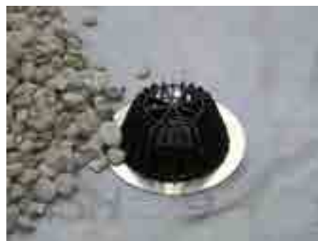
11. Uzstādīt lapu ķerāju, apbērt sagatavoto kolektoru ar granti (frakcija: 20+40 mm)
