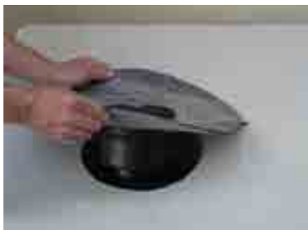
1. Sagatavot Ø 255 mm atveri, piestiprināt kolektoru HL62H
